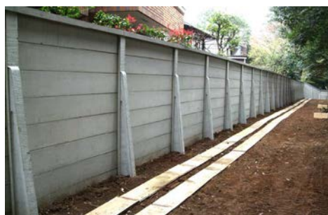
施工例；「コンクリート製組立塀」
