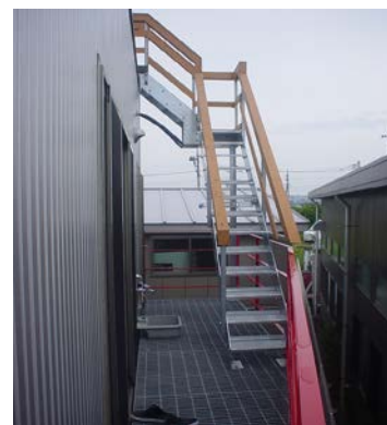
屋外階段(亜鉛メッキ)
