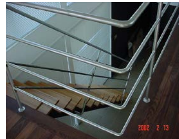
室内階段手摺
