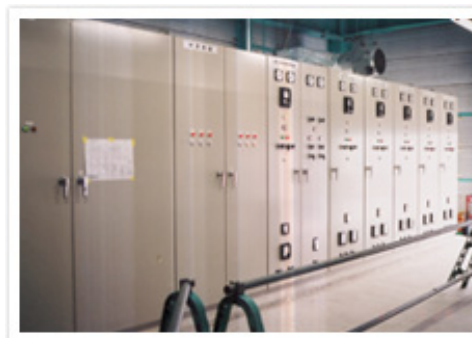
高圧受変電設備、低圧配電設備 設計・製作
